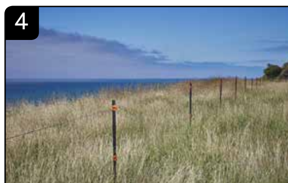
4 Monter derefter mellemstolperne
